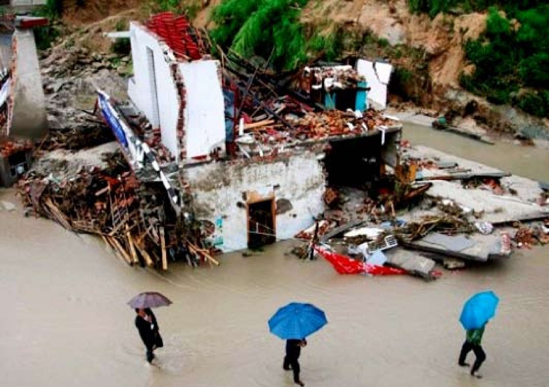
Deslizamiento de tierras en la localidad de Zhanqiao, China (2011)
