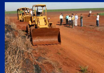
378,02 km Colocación de cascotes
