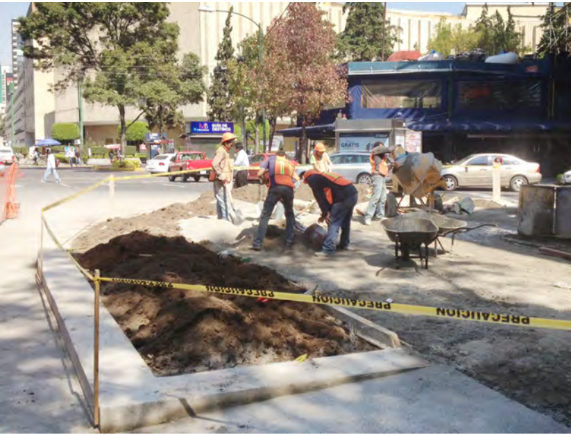
Figura 16. Obras generadas por EcoParq
