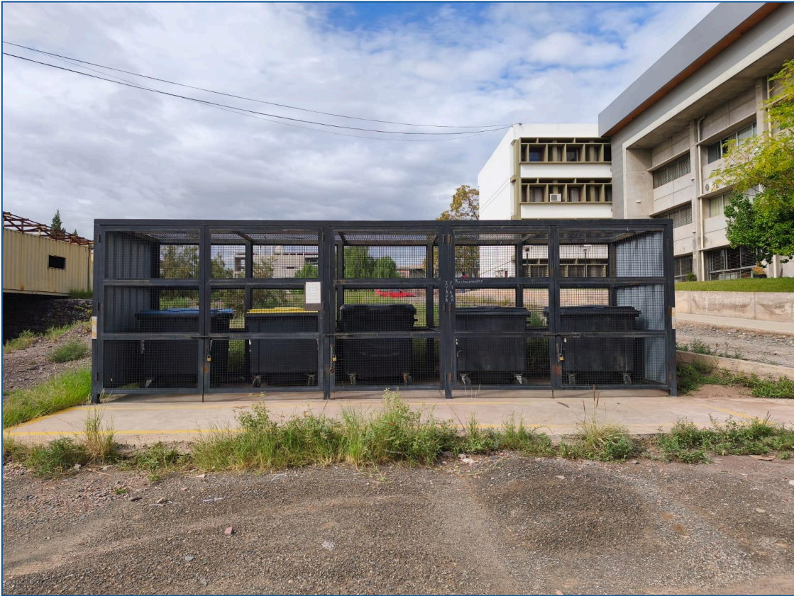
Imagen 22: Plataforma de contenedores ITU-FFYL
