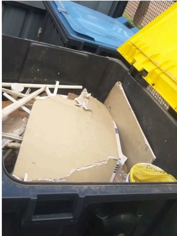
Contenedor amarillo utilizado para el depósito de escombros y restos de construcción.
