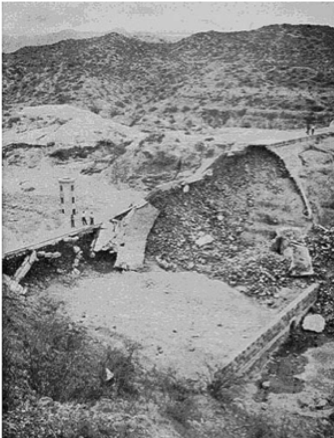
Figura 1: Rotura del dique Frías. Foto Diario Mendoza 1970
