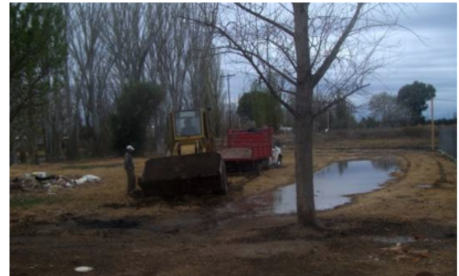
Figura 5: Pérdida de Capacidad Portante por Proceso de "sub-inundación" (migración subsuperficial del agua de riego excedente entre propiedades limítrofes).
