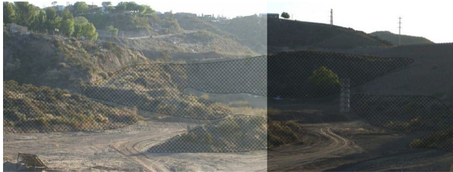
Figura 6. Imagen fotográfica tomada aguas abajo del dique Frías, en esta puede observarse en niveles superiores urbanizaciones. Con trama cuadriculada se destacan los depósitos de material.
