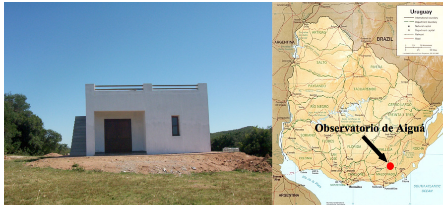
Figura 8 – Sala de control del Observatorio de Aiguá (en construcción) y ubicación del lugar.
